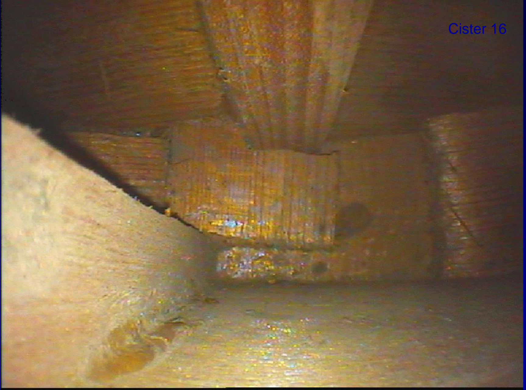
Innenkonstruktion: Decken- und Bodenberippung
